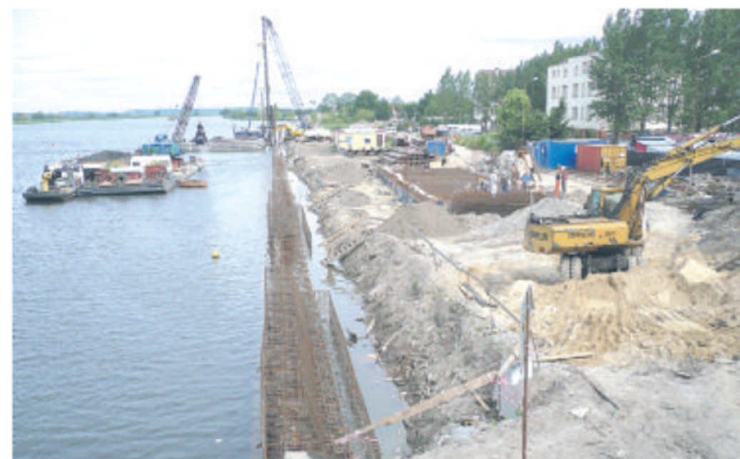
II etap realizowanej przez szczeciński Energopol budowy nabrzeża. Tu trwają jeszcze prace ziemne i hydrotechniczne.
